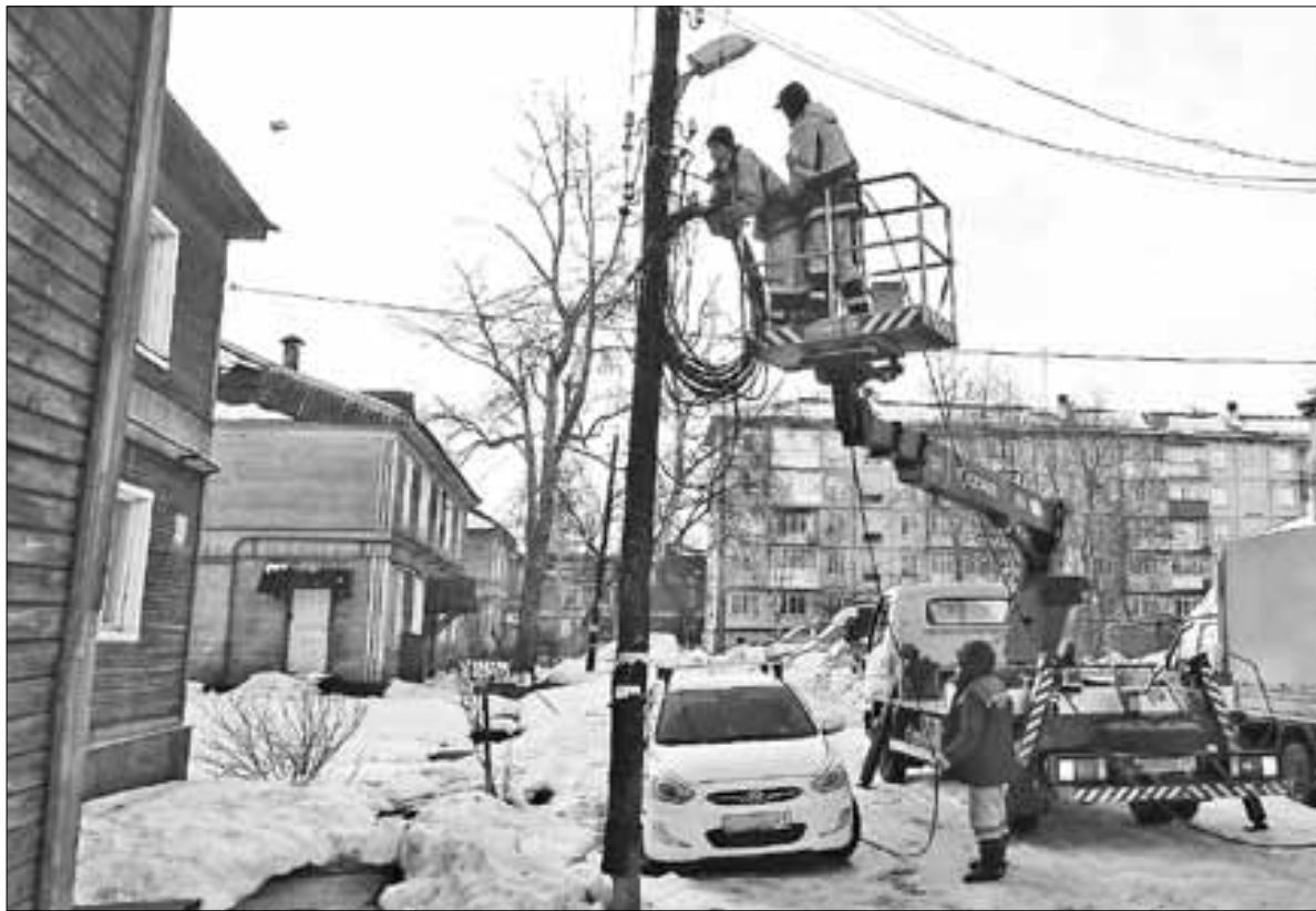
■ Плановая замена алюминиевых проводов на самонесущий изолированный провод
